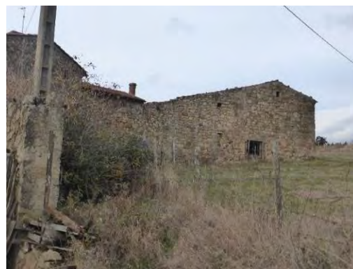
Vue éloignée depuis l'est
