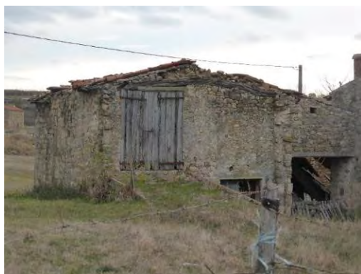
Vue depuis l'ouest
