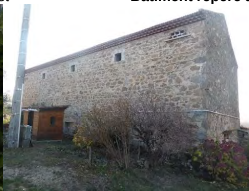
Vue depuis le sud
